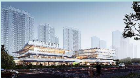
嘉兴运河湾新城城市有机更新项目
