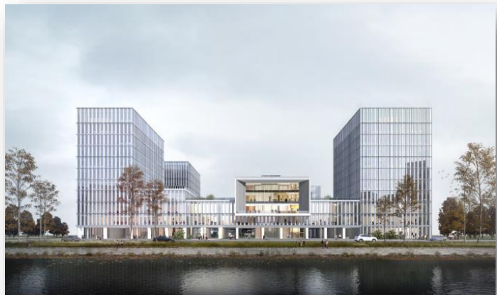
总部基地：华云电力研发总部
